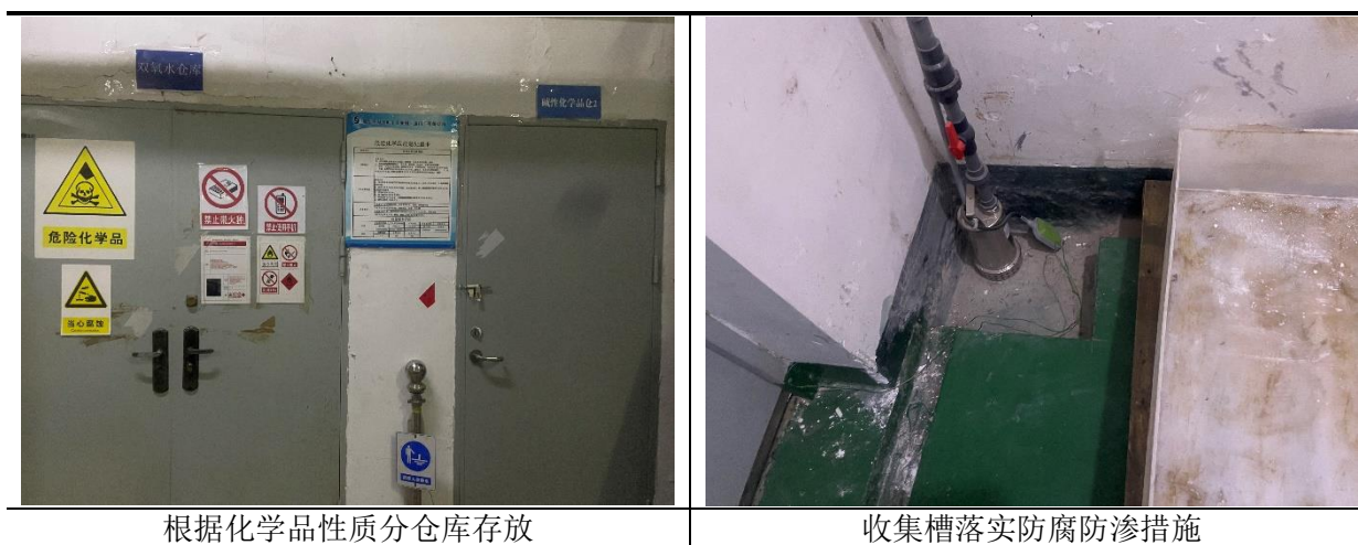
图 4.1.4 货物储存和传输土壤污染预防现场情况
