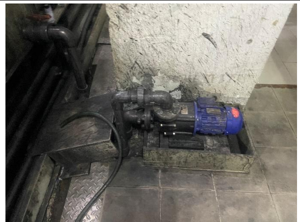
管线及输送泵下方设防腐防渗措施
