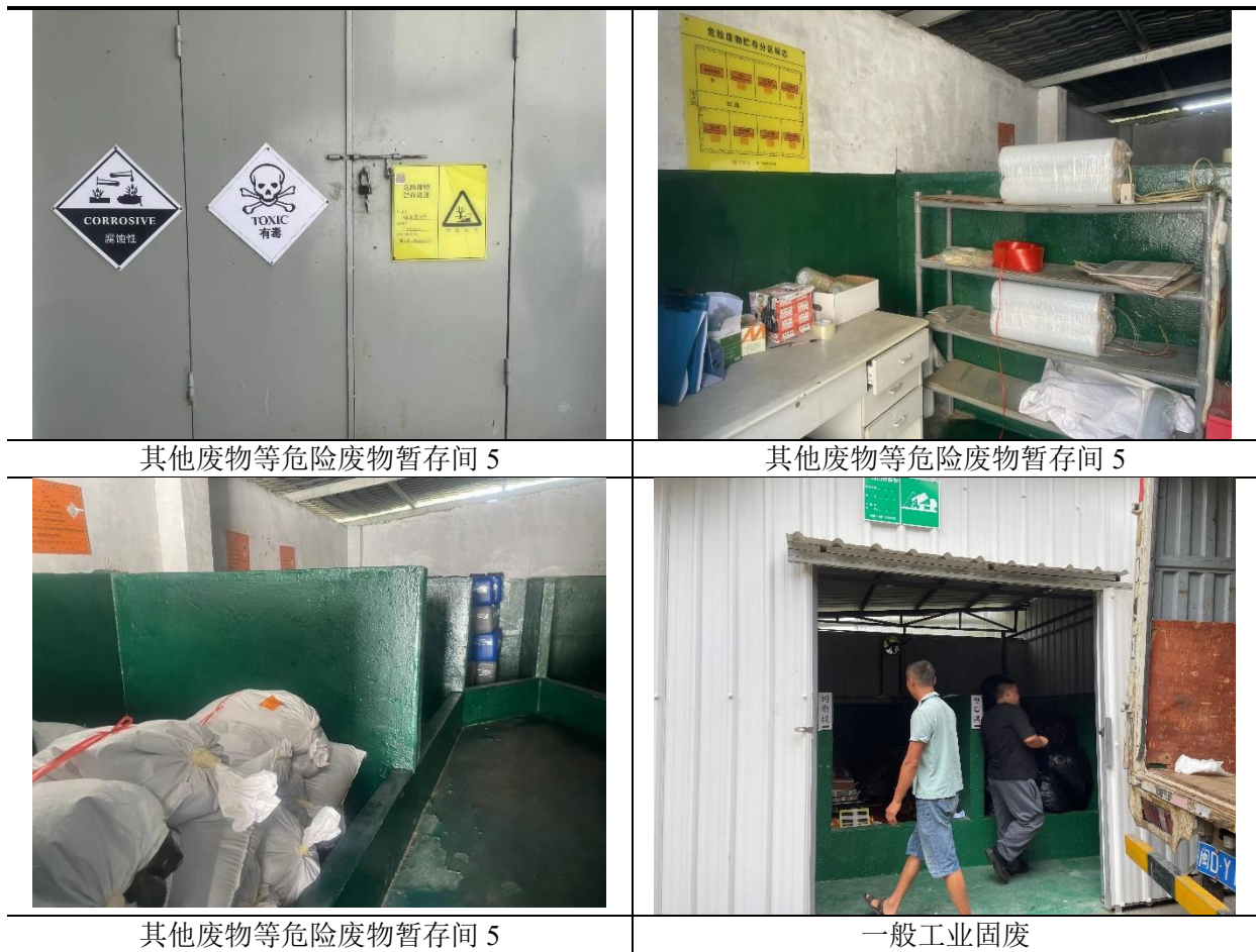
图 2.8.5 各类固体废物暂存库
