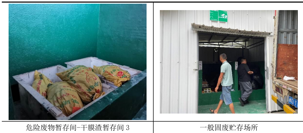
图 4.1.8 固体废物暂存场所土壤污染预防现场情况
