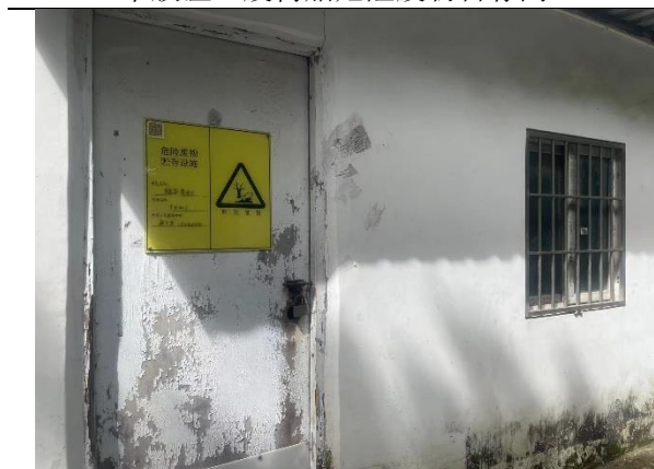
报废菲林等危险废物暂存间 4
