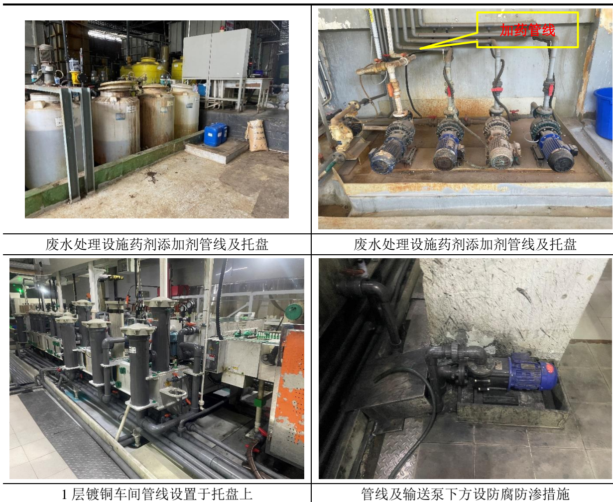
图 4.1.3 管道运输土壤污染防治现场情况
