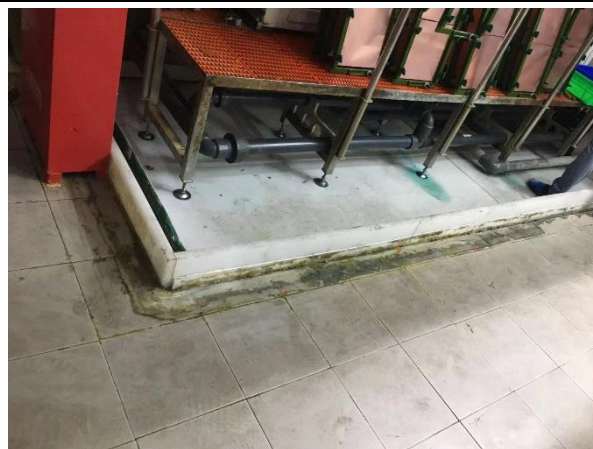
电镀生产线围堰
