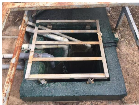
电镀生产线内废水分质分流管线
