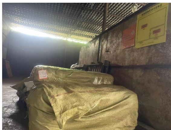
污泥危险废物暂存间 2
