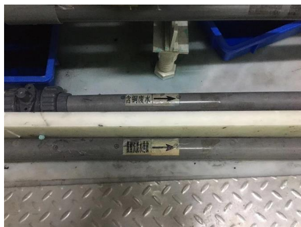
电镀生产线内废水分质分流管线
