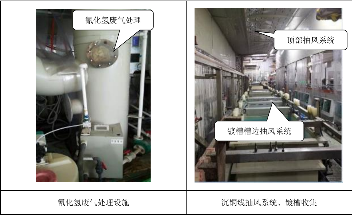
图 4.1.14 废气收集处理设施情况
