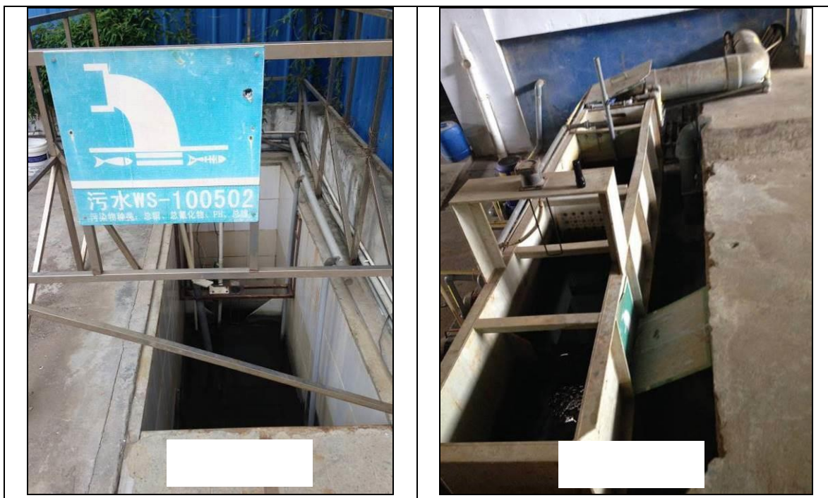
图 3.4-10 电镀废水处理设施
