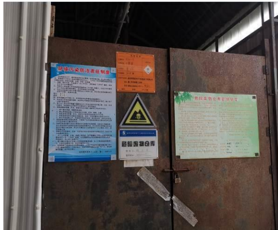
干膜渣、废树脂危险废物暂存间 3
